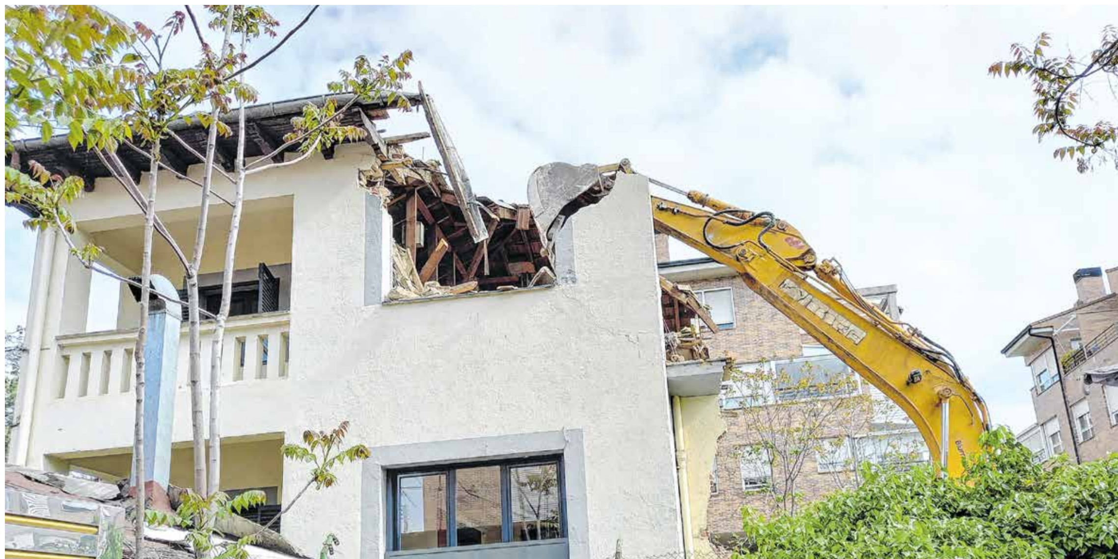
Die alte Schule wird abgerissen: Stück für Stück verschwinden seit Jahrzehnten die Bauten des Ideengebers Arturo Soria. Erst jetzt regt sich Widerstand.
