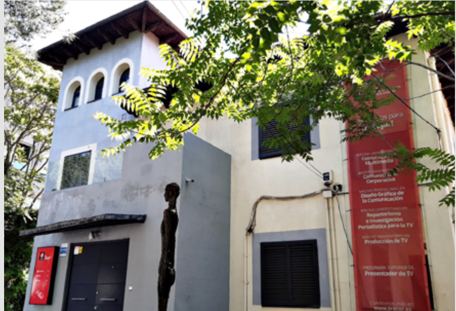
Chalé de la calle López de Hoyos construido en los años treinta y demolido el pasado mes de abril. BEATRIZ KELLER
